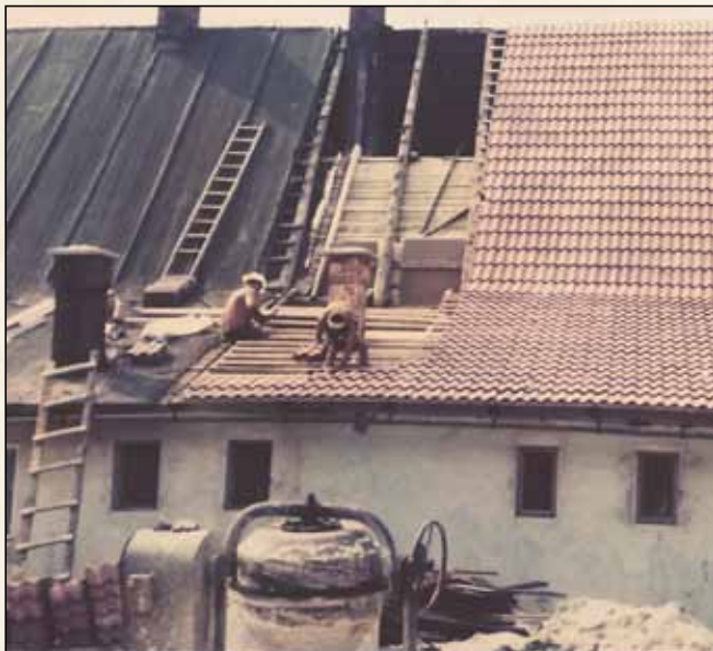
Remont pierwszej siedziby Centrum
